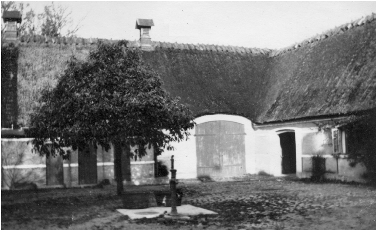
Strødam Avlsgårds nord- og østlænger med ungt valnødtræ på gårdspladsen. I midten ses vognporten, og til højre i billedet ses en del af den fløj, der bl. a. rummede boksrums til føl og kalve. Ca. 1925.
