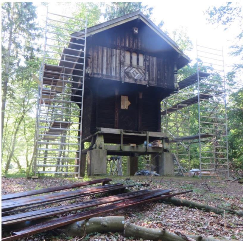
Norskehuset under renovering i 2018, foto Lene Dabelsteen
